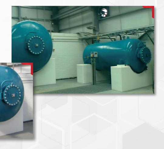
: IRAQ TIKRIT 50-200m³/ h PRESSURIZED SAND FILTER
